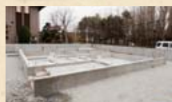
4月には基礎工事も完了！ いよいよだ。
