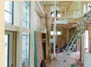
ハシゴを渡した2階へは、螺旋階段が作られる予定だ。
